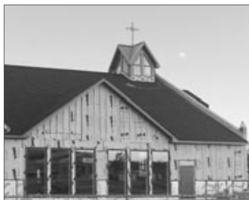
Le clocheton est installé.
