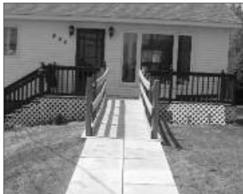
La rampe d'accès terminée.
