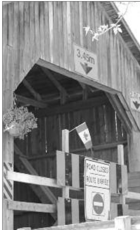
Le pont fait partie de nos vies et de nos habitudes, il faut le garder en service.
